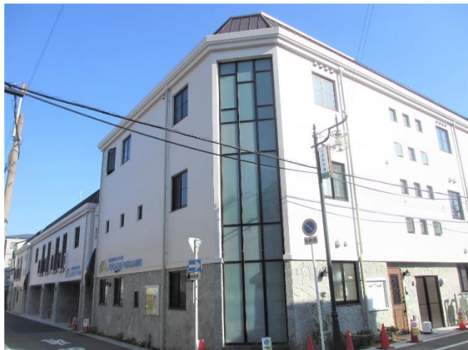
天使保育園 天使ベビーセンターの新園舎
